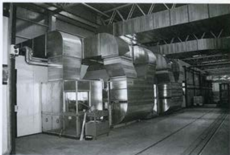
Fig. 16 - I gruppi di aspirazione e filtrazione aria della seconda linea di verniciatura
