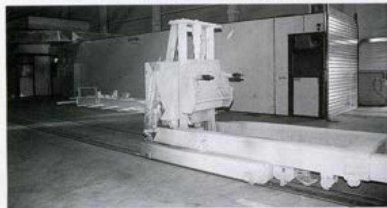
Fig. 18 - Finite le operazioni di verniciatura e scaricato il rimorchio, il carrello torna alla sua posizione di partenza
