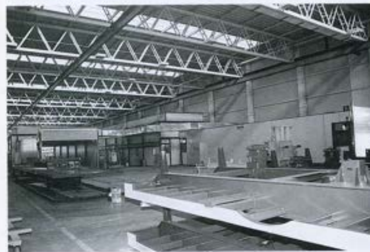
Fig. 14 - Vista generale del forno di cottura degli smalti all'acqua (sulla destra). In primo piano le strutture metalliche dei rimorchi, di vari colori, pronte per essere inviate "just in time" al montaggio
