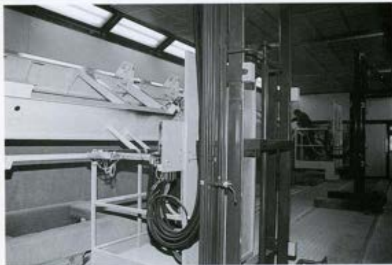
Fig. 11 - Particolare dell'interno cabina di spruzzatura del fondo anticorrosivo epossidico a due componenti acquosi. Due ascensori - discensori, comandati dagli operatori, permettono una completa ricopertura del rimorchio, da parte dei due verniciatori che si movimentano anche longitudinalmente. I verniciatori comandano, seconda necessità, anche la rotazione del rimorchio agganciato sul carrello portapezzi, illustrato in fig. 8
