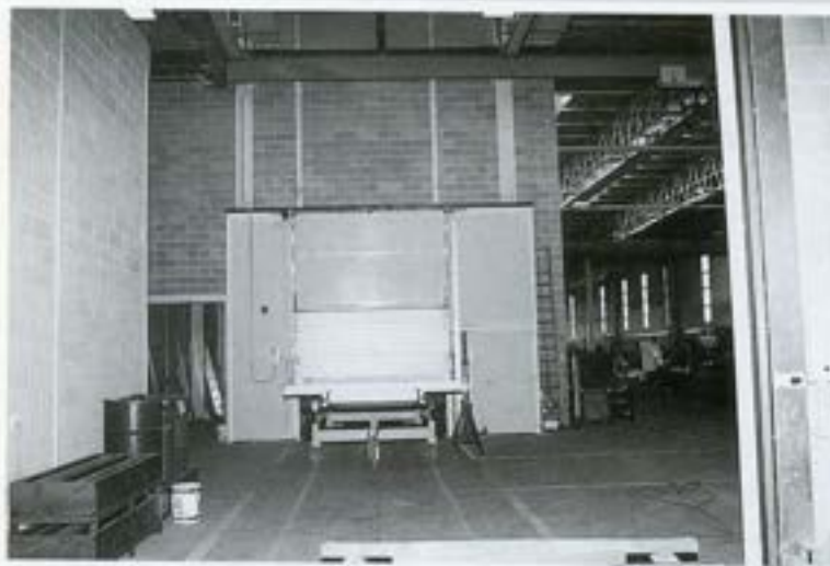
Fig. 3 - Vista generale dell'impianto di granigliatura delle strutture metalliche dei rimorchi e dei loro componenti, durante l'operazione di trattamento
