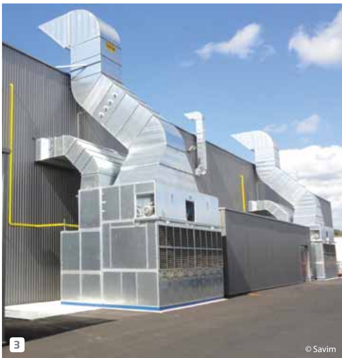
3 The plant's filtering and ventilation systems. Sistema di filtrazione e ventilazione dell'impianto.
