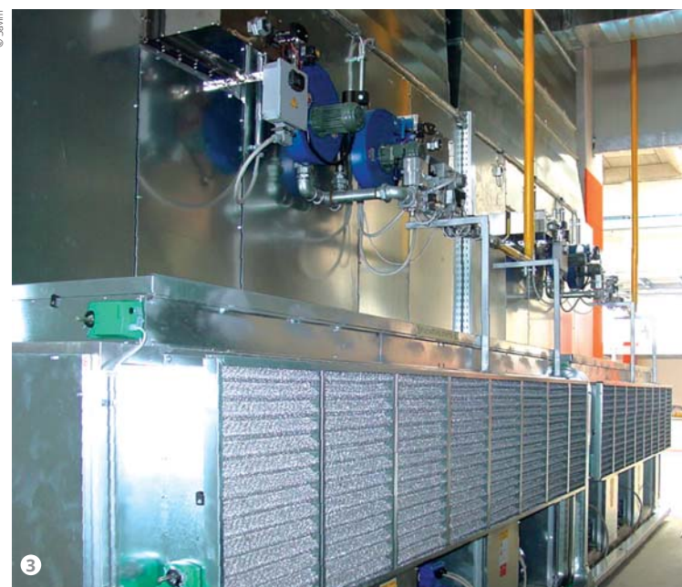
Figura 3: Gruppi di riscaldamento in vena d'aria per cabina forno di Savim.
