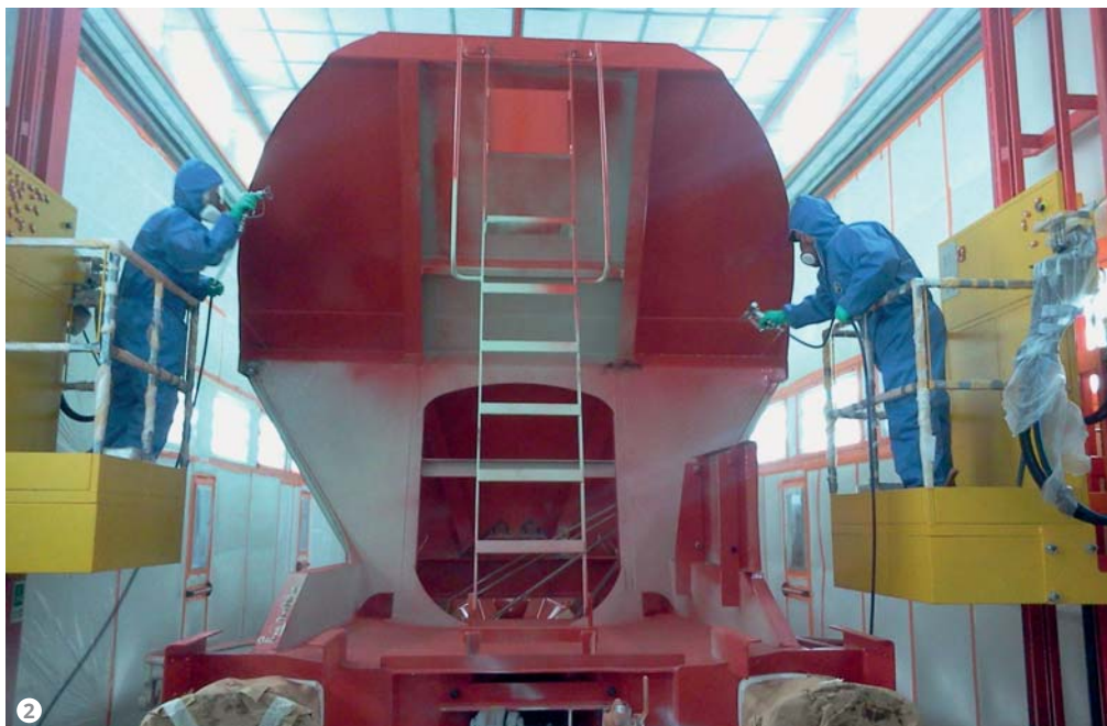
Figura 2: Ogni singola cabina avrà un funzionamento autonomo, uguale o diverso dalle altre. Sarà il PLC che gestirà il ciclo, l'operatore darà solo il consenso in base alla sua posizione.
